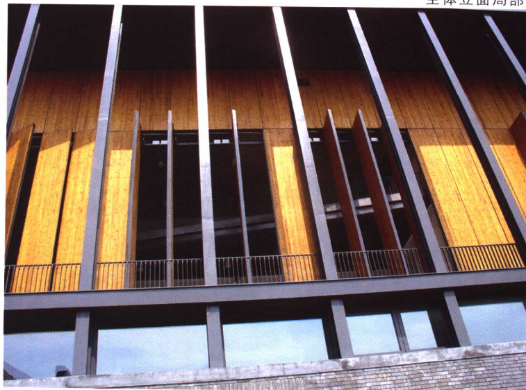
主体立面局部
