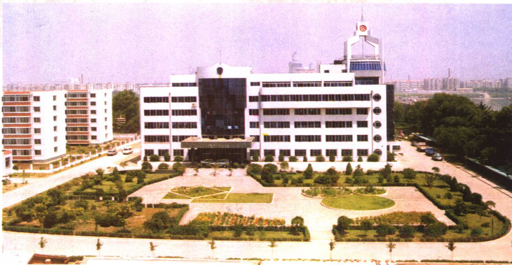
▲ 公路处机关办公楼
