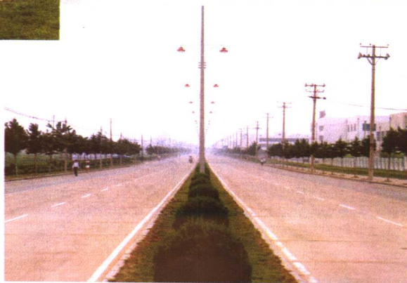
▲疏港一级公路
