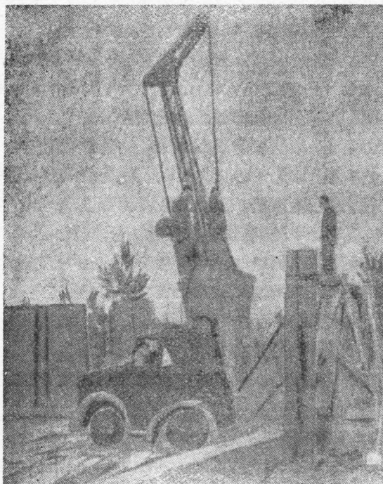
圖 6 用万能裝卸机安裝窗下予制板的情形
