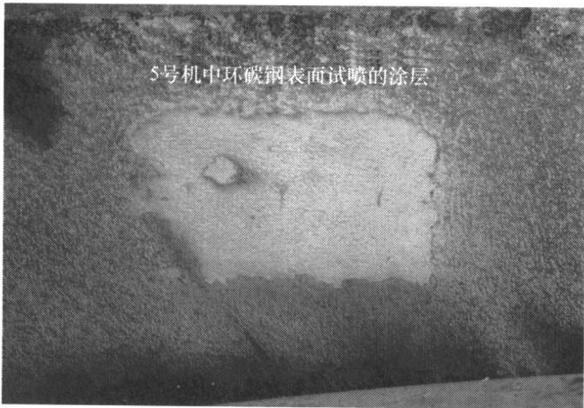
图 2 黄河上某低水头电站水轮机转轮室中环表面试喷情况
