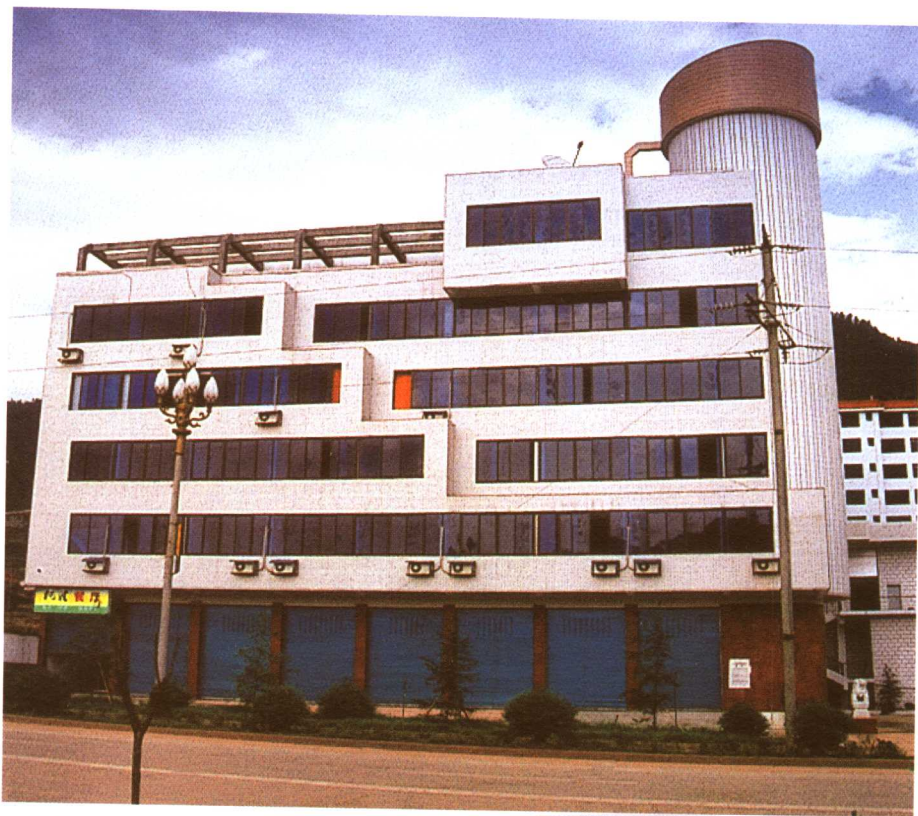
地局（分公司）机关办公楼（1997年）
