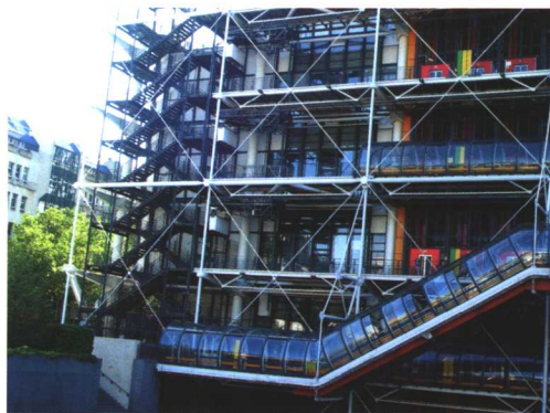
图 2-2 巴黎蓬皮杜 艺术文化中心。运用钢 材、玻璃等新型建筑装 饰材料对建筑 墙体进行保 护
