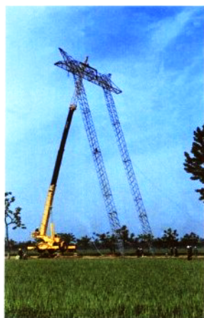
吊车整立500kv输电线路铁塔
