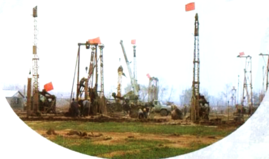
桩基施工现场
