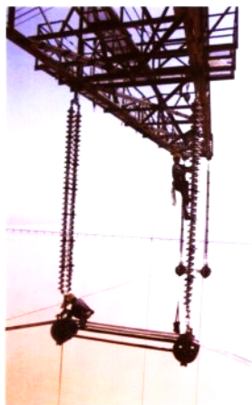
横跨黄河安全施工
