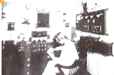
无线电通讯室
