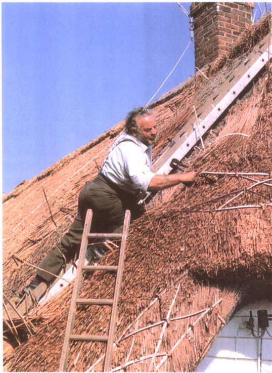
盖茅草屋顶的匠师在英格兰南部、威尔士和爱尔兰的许多地方仍是需要的。他们为老房子的屋顶铺上新的草料或者修补茅屋顶。
