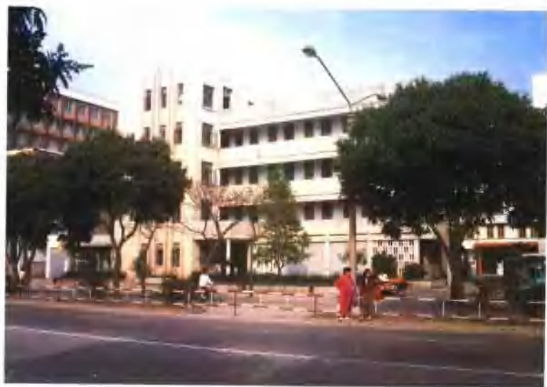
福建省泉州市对外贸易公司大楼
