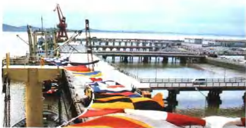
泉州后渚港3000吨级码头
