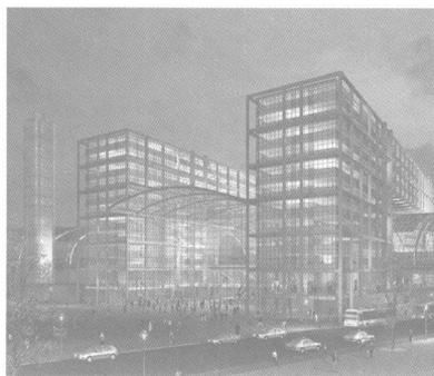
我们来看看几何比例，或者说该项目的纯粹尺度。该综合建筑的建筑面积16400 m<sup>2</sup>，其中75000 m<sup>2</sup>作为商用，4300 m<sup>2</sup>为铁路服务用房，19500 m<sup>2</sup>为交通面积，余下的35000 m<sup>2</sup>为站台本身。对于简单规则设计的车站，听起来如同天文数字，但对其总的布局详加分析，实际上它有着独到的复杂的三维空间安排。这是精心组织的城市空间的内爆和多种功能(包括城内服务)错综复杂的组合。车站的重心分布在两个层面上，一是车站层15m以下深处的隧道，城际特快列车ICE(横贯德国东西的高速列车)通过这里；另一个是地下10m处南北走向的地铁(另一条高速铁路)。冯·格康在把这座国际铁路枢纽转变成极有影响的市中心方面表现出高超技能。
