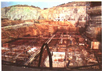
秦山核电站施工现场
