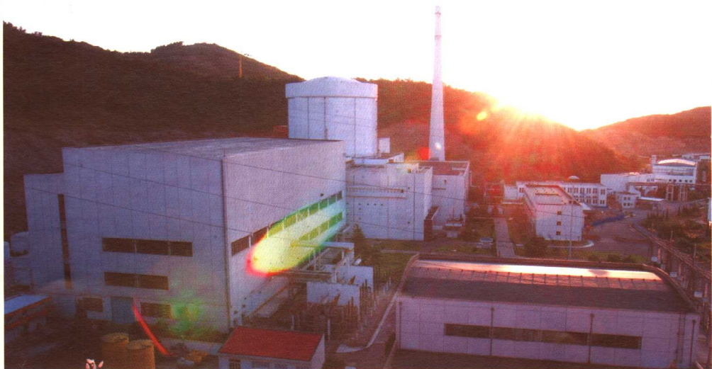
秦山核电站全景
