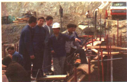
正在建设秦山核电站的人们
