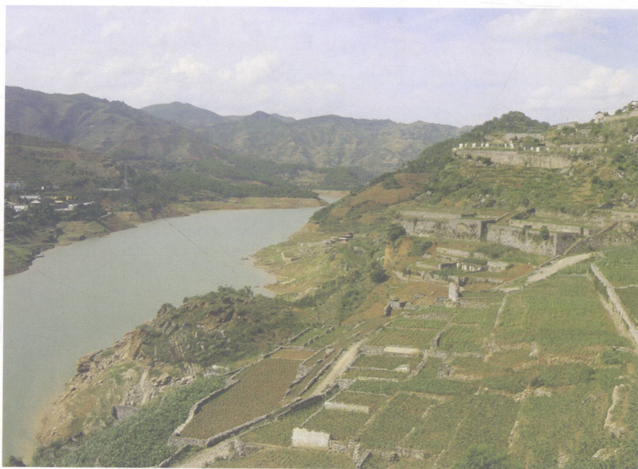
移民新址坐落在古滑坡台阶上, 水库水位下降后诱发滑坡, 危及村庄 (鲁布革电站贵州库区, 2001)
