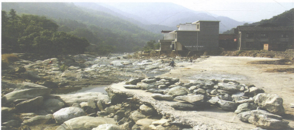
江西庐山 5 天降雨量达 980 毫米，引发泥石流灾害（2005）
