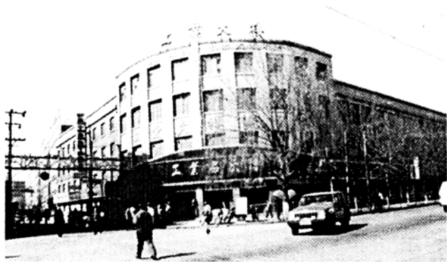
▲拆去旧楼建新楼 原工业大楼已被拆除
