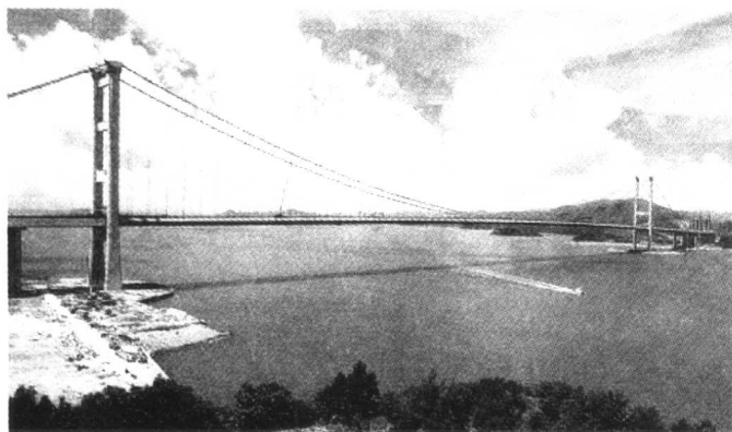
(a) 香港青马大桥主跨长度 178 m, 混凝土桥塔高 206 m
