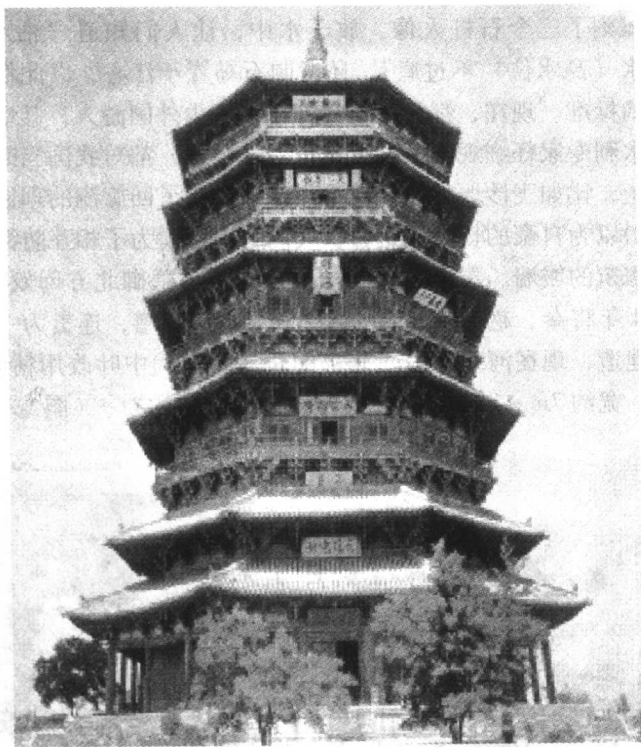
图 1-8 山西应县木塔
