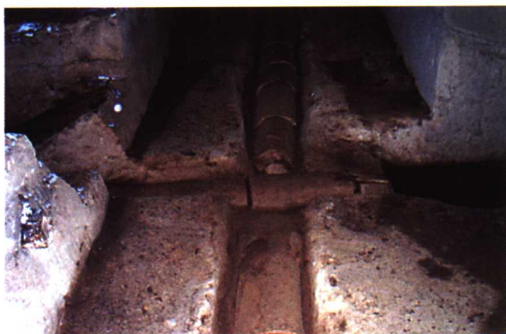
彩图1 古代城市已有良好的排污设施,图为河南虢国都城遗址的下水道
