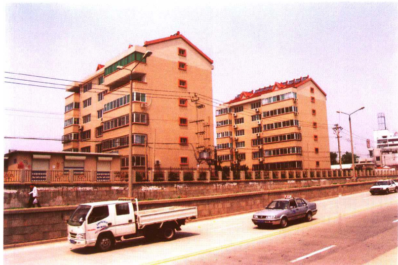
地处小张庄境域的居民楼建设。楼下为历黄路立交桥
