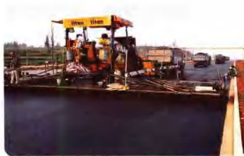
建设中的呈贡新城主干道
