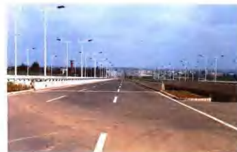
竣工通车的呈贡新城主干道
