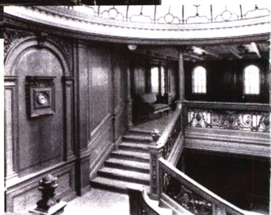
真实的泰坦尼克号的楼厅
