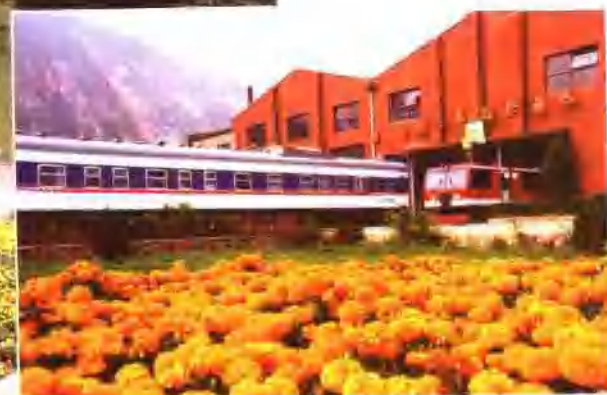
空调客车检修基地 薛建民 摄
