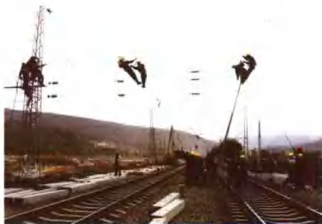
接触网工程施工
