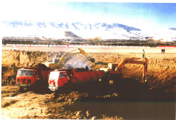
兰武二线工程乌鞘岭隧道开挖
