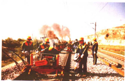
天兰线水害抢险 确保运输畅通
