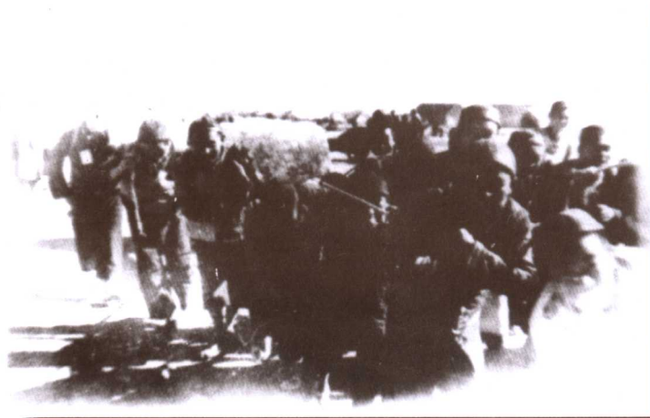
临桂县秧塘机场的民工在拉动大石碾，压平供美国“飞虎队”飞机起降的机场跑道。
