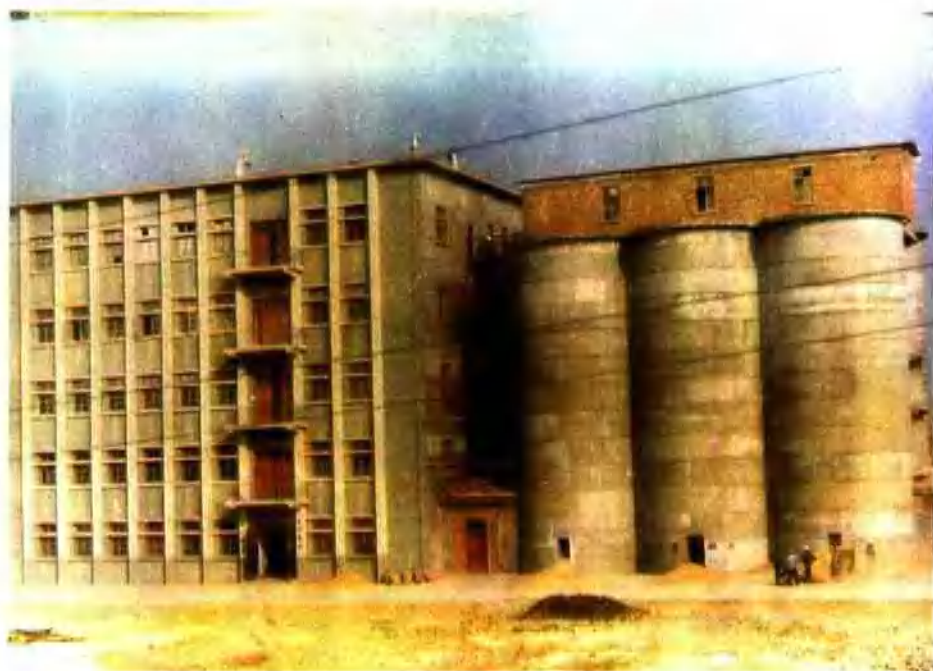
宁陵县面粉厂粉楼外观
