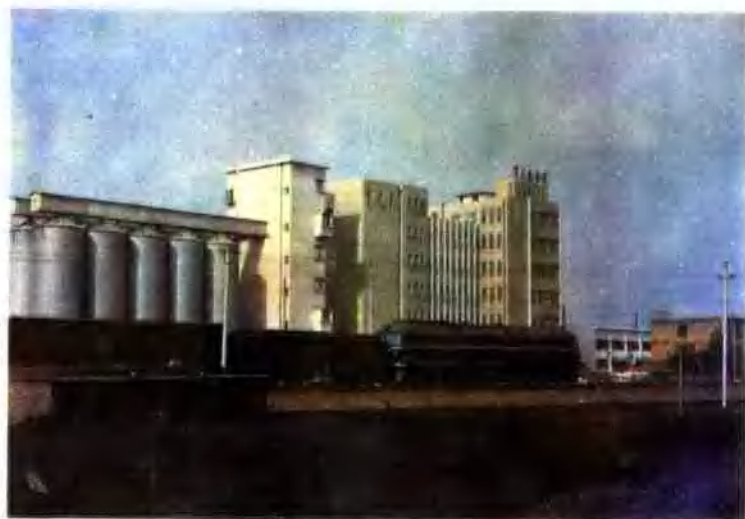
尚在市面粉厂扩建后 的新厂景
