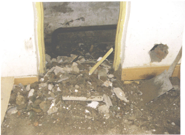
1-1-8 用垃圾回填室内地面
