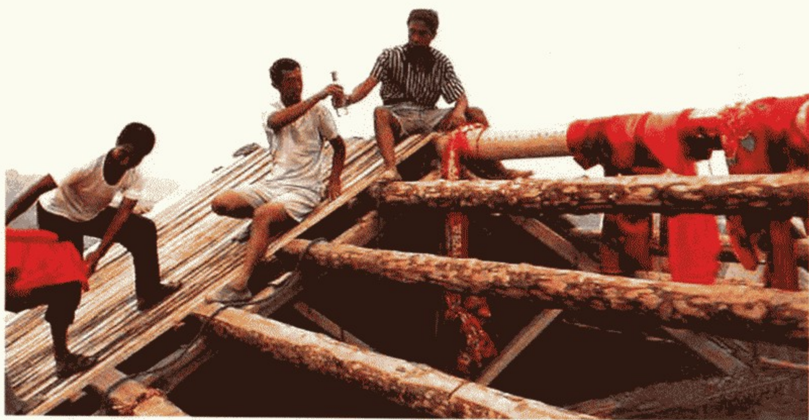
上梁中的浇梁仪式
