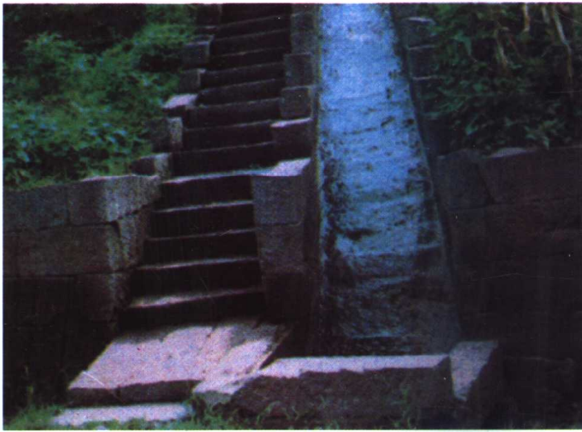
排洪渠及人行路
