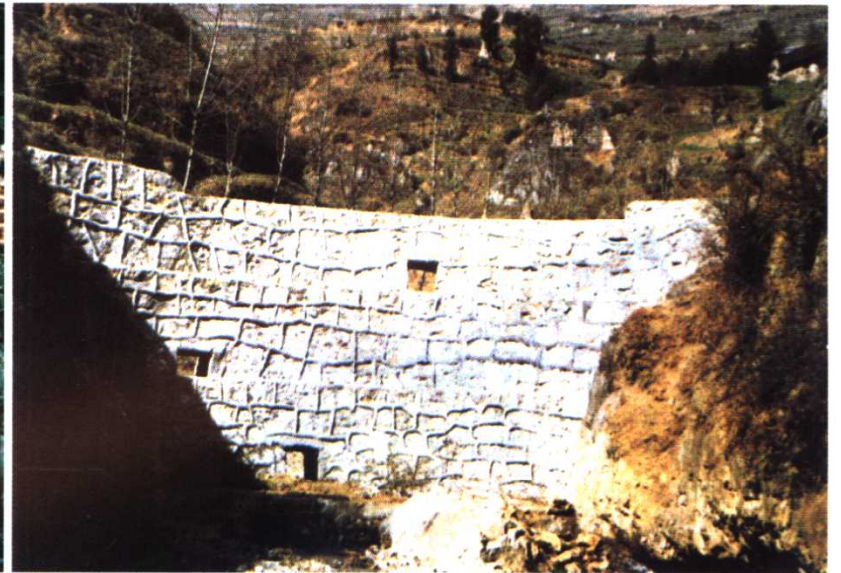
浆砌块石拦沙坝
