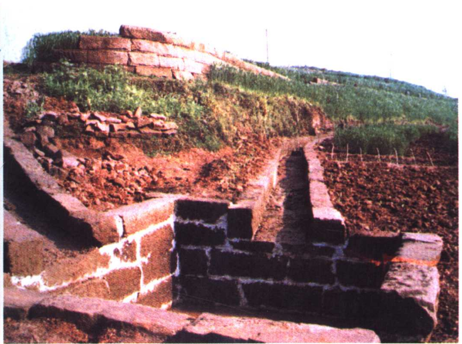
沉沙池及排洪渠
