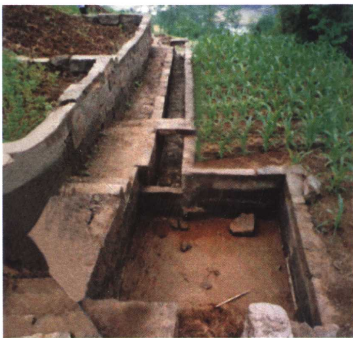
沉沙池及灌溉渠
