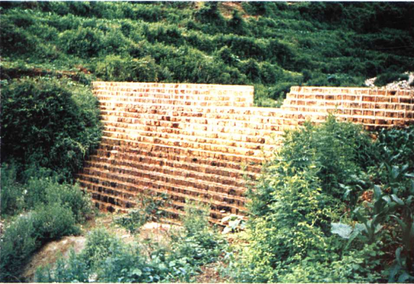
浆砌条石拦沙坝
