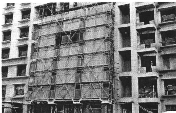
图 4 斜爬脚手体系
