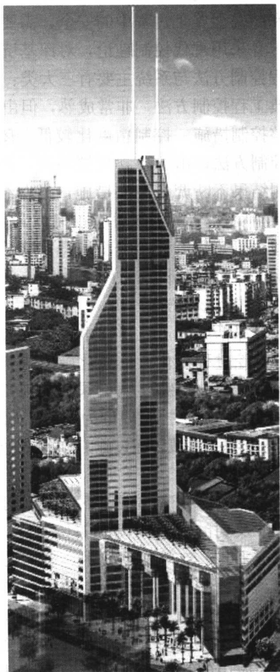
图 2 上海世茂广场
