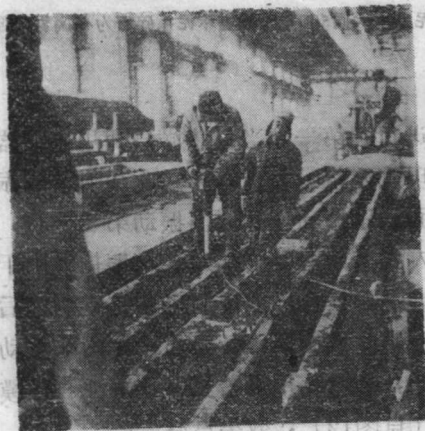
圖 13 第二次台震盪情况
