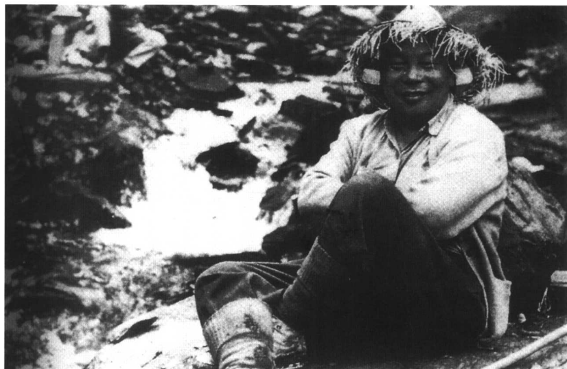
1950年代，头戴斗笠的蒋经国巡视台湾中部横贯公路的施工情形，休息时露出愉悦的笑容。
