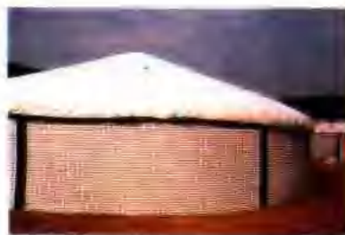
一种新型的储粮设施——PVC圆形移动快仓正在进行1000吨小麦装粮试验及装粮后外形图片
