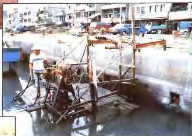
南方澳漁港碼頭永久地錨施工
