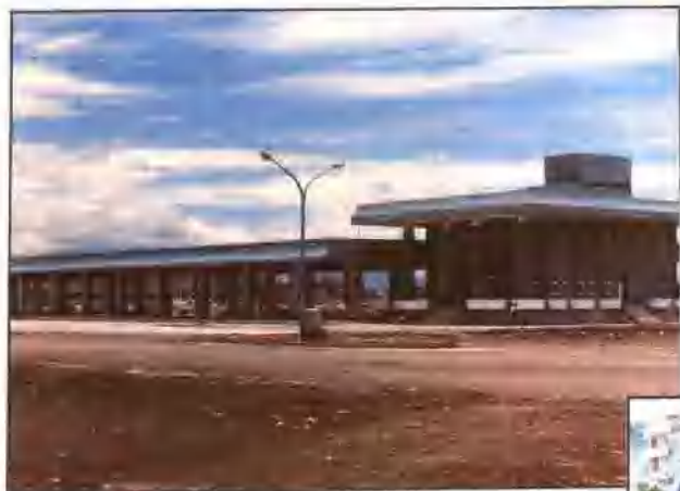
東港漁港魚市場預力樑工程
