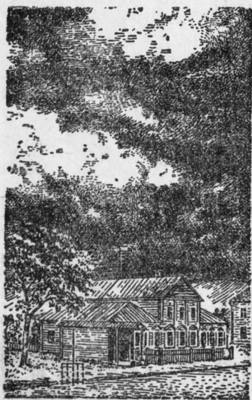
圖5. 房屋上的避雷針
