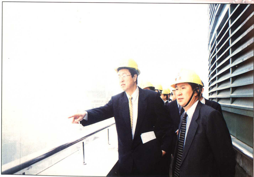
1998年4月，中国建设银行周小川行长在分行张恩照行长陪同下视察位于浦东陆家嘴的分行新大楼工地。
