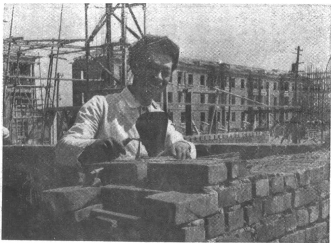
平壤工人公寓興建情形
