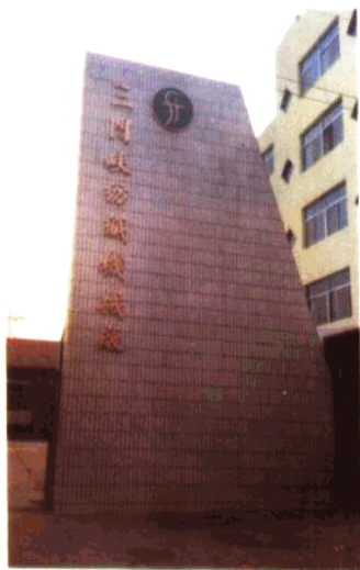
三门峡纺织机械厂新建的厂房
