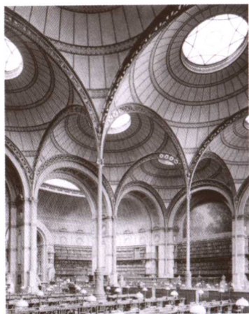
图1-1-7 1859—1867年间建造的法国国家图书馆，屋顶由一组小的玻璃穹顶组成。
