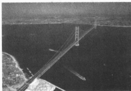
图 1-6 日本明石海峡桥
