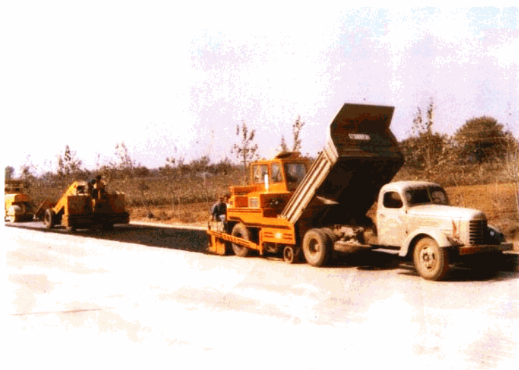
许扶路机械化施工
