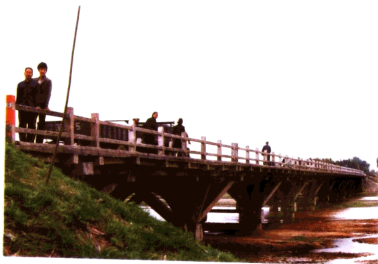
鲁山彭河大桥(钢筋混凝土撑架连续板)
