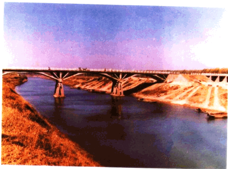
郾城滙河大桥(刚架拱)
