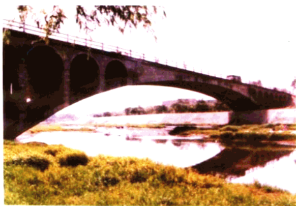
禹县北关大桥(双曲拱)
