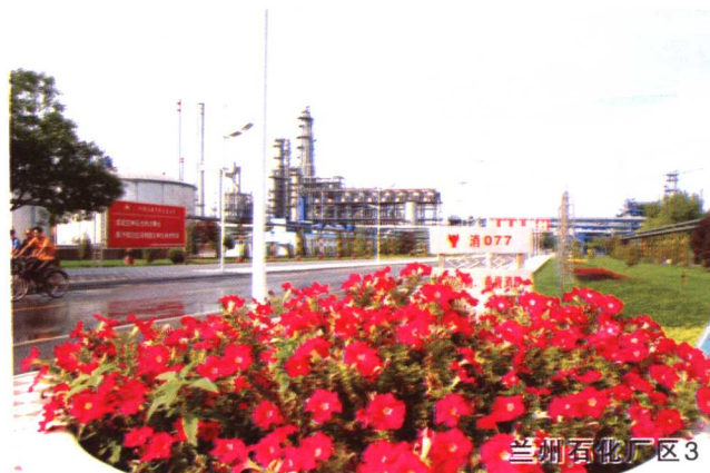
兰州石化公司年60万吨大乙烯开工建设
