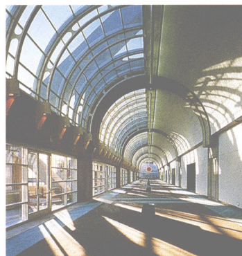
圣迭戈会展中心 (San Diego Convention Center) 美国，加利福尼亚州，圣迭戈 迪姆斯·刘易斯·麦金利 & 洛施克·马夸特 & 内 绍姆，阿瑟·埃里克森建筑师事务所 (Arthur Erickson Architects with Deems Lewis McKinley & Loschky Marquardt & Nesholm) 合作设计 3 张拉膜屋顶覆盖下的展览和活动区 4 拱桶形休息厅下的夹层部分 5 上部夹层 照片提供：courtesy Arthur Erickson Architects
