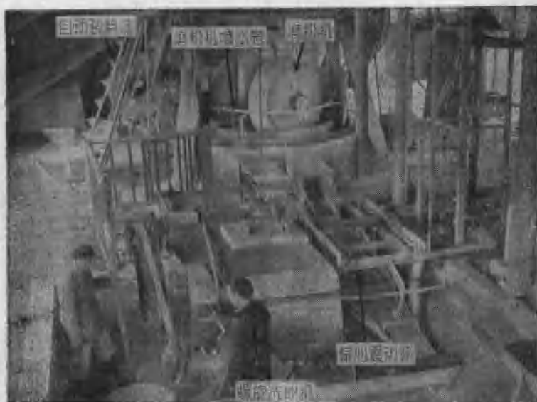
圖 9. 石英粉濕式生產主要設備
