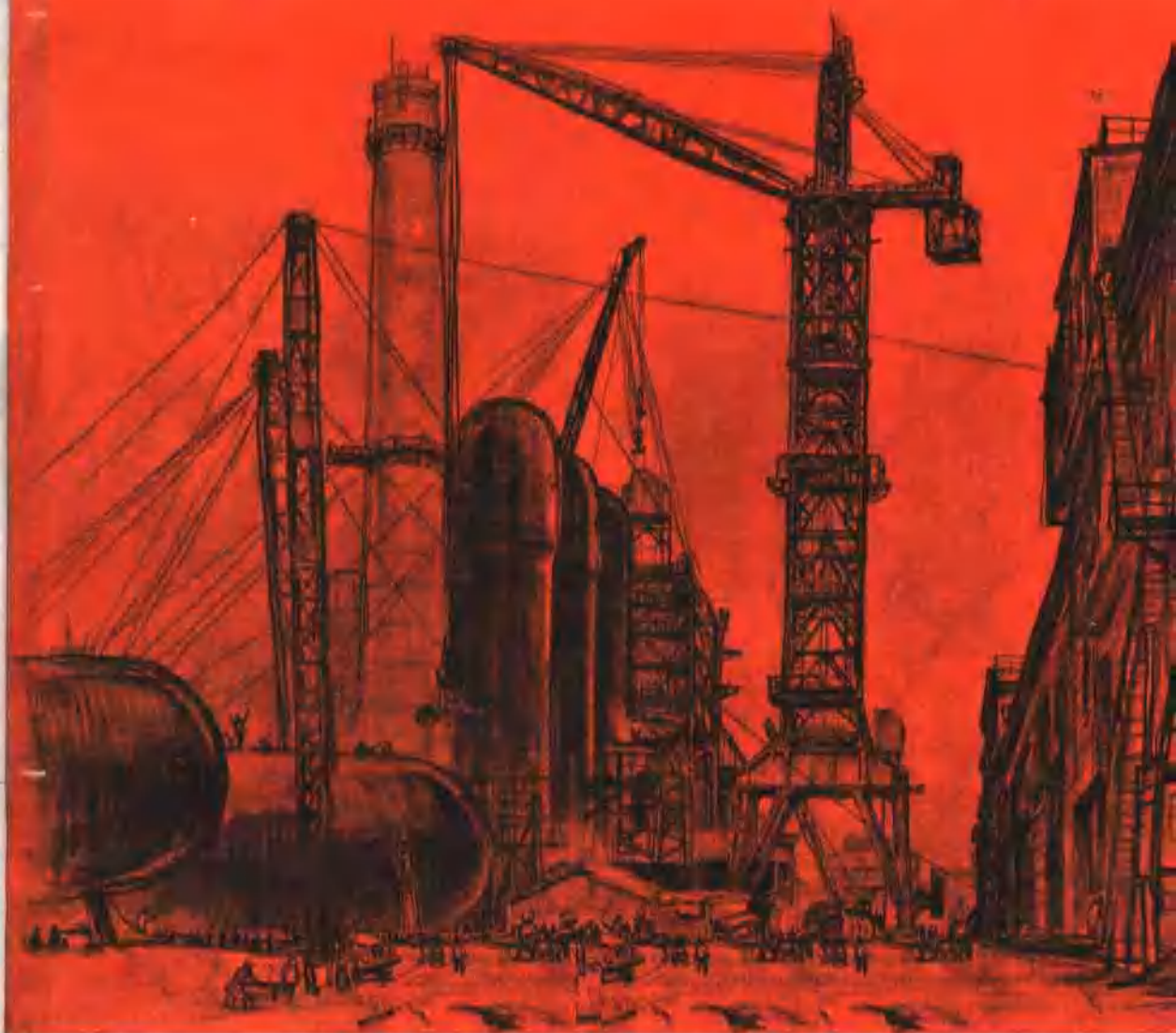
九四二四厂工地速写
