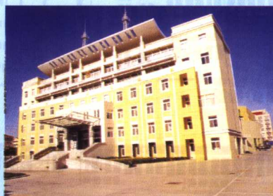
江苏边防总队太仓海警支队办公综 合楼(10875M 2 K6 获2003年度“ 扬子杯”奖、2005年全国用户满意 工程)
