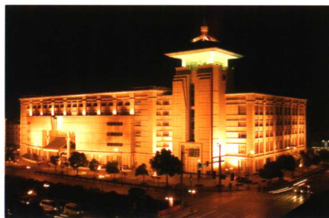
苏州国税综合业务大楼 (2004 年度鲁班奖)
