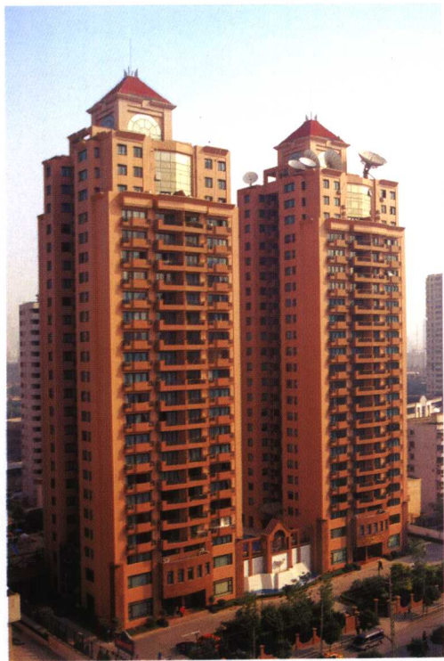
上海法华苑高级商住楼（鲁班奖工程）
