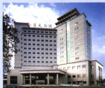
哈尔滨医科大学附属第二医院外科医技楼工程——2003 年度“鲁班奖”工程
