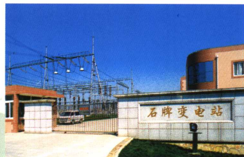
500KV 石碑变电站 (2003 年度鲁班奖)
