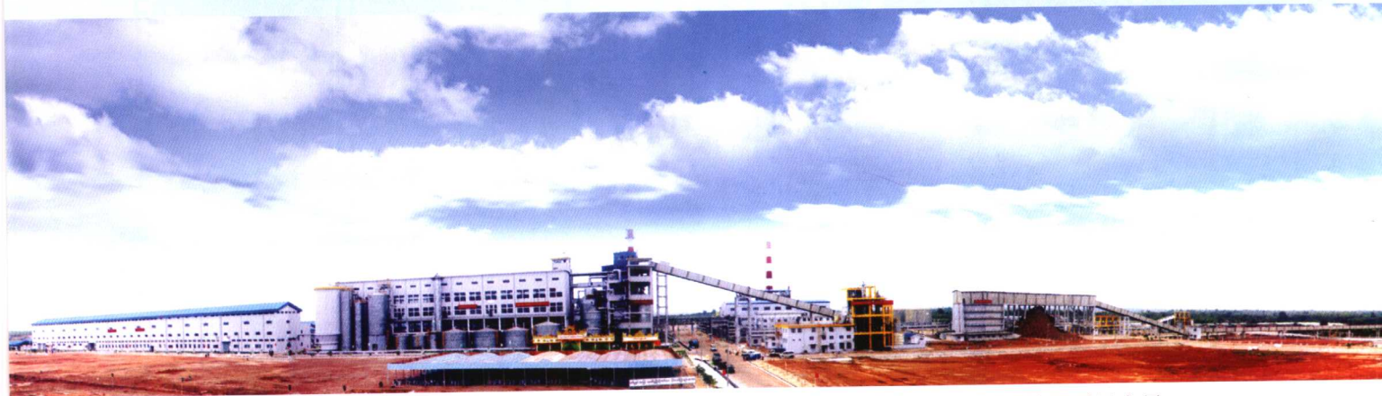
缅甸大巴日产200吨纸浆厂项目全景 (该项目于2005年5月14日竣工投产)
