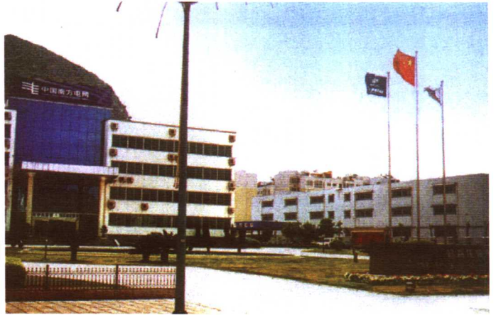
黔西南超高压输电公司
