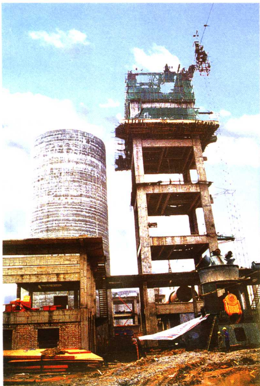
建设期间的顶效瑞安水泥厂
