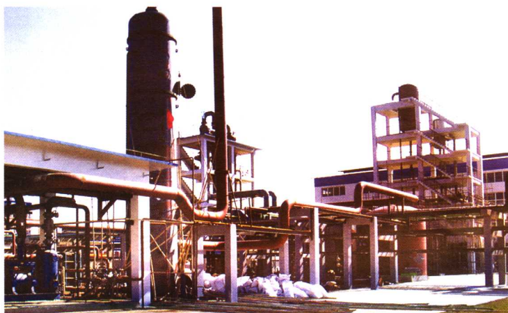
总投资4亿元的省、州重点工程项目——安龙重化工基地。
