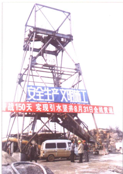
■ 竖井施工井架
