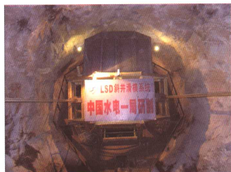
■ LSD 斜井滑模系统施工
