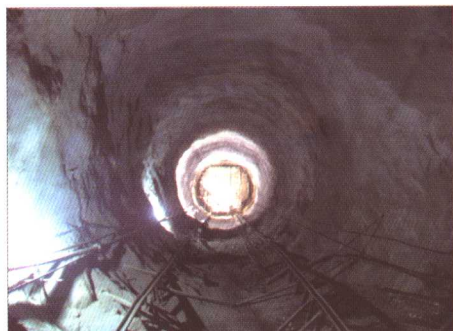
■ 斜井扩挖施工
