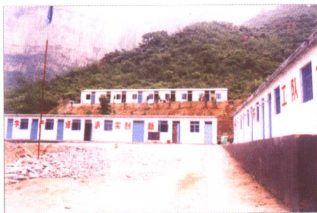
■ 施工临时营区
