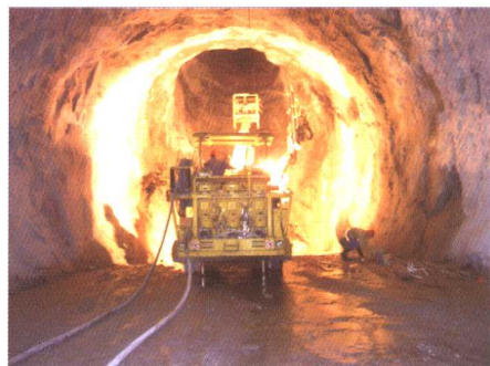
■ 斜井下弯段施工
