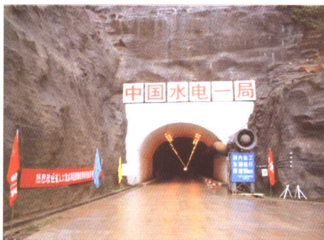
■ 施工支洞洞口
