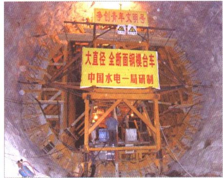
■ 平洞混凝土衬砌施工
