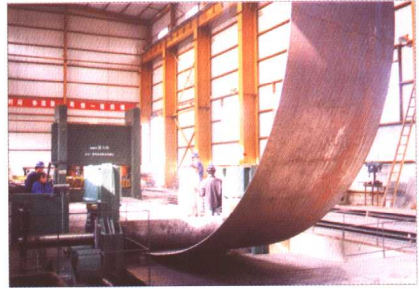
■ 钢管卷板作业
