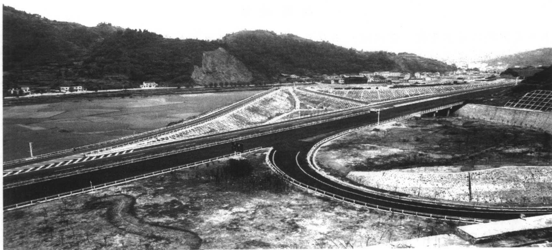
台江互通立交桥
