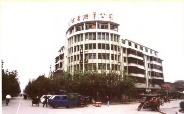
峨眉山市烟草公司办公大楼
