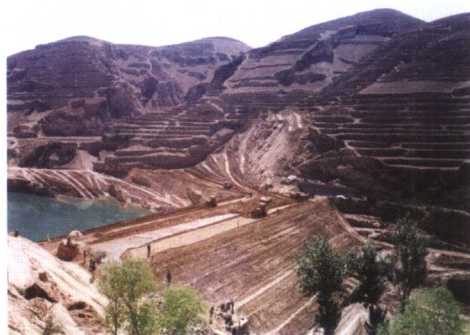
骨干工程建设现场
