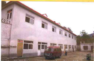
德威公司西南煤矿办公楼
