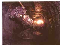
吕梁山煤电公司综掘工作面
