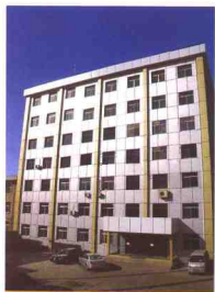
离石区煤炭安监大楼
