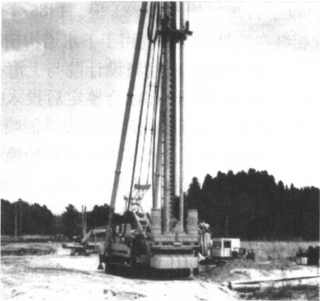
图 1-5 日本陆上工程标准的 DJM 施工机械 (Terashi M., 2003)
